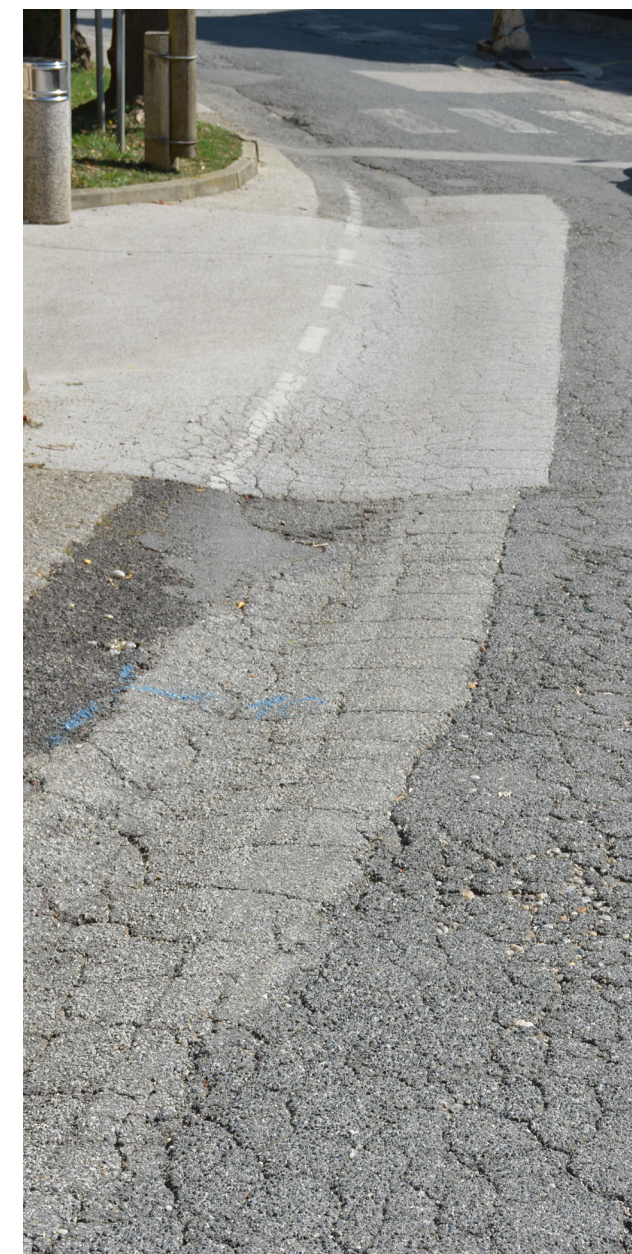
Slika 18: Izsek dotrajanega asfalta v centralnem delu naselja Sveta Trojica v Slovenskih goricah
